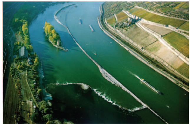
Binger-Loch-Strecke des Rheins mit dem 1994 gebauten Leitwerk (Blick zu Tal, links die Mäuseturm-Insel)
