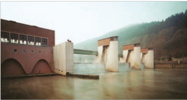
Krafthaus und Wehr Rockenau am Neckar (1933)
