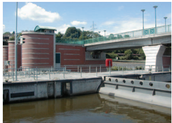
Wehrpfeiler und Schleusenobertor der Staustufe Saarbrücken
