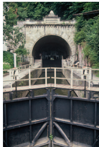
Schifffahrtstunnel Weilburg/Lahn (L = 195 m) mit Koppelschleuse, erbaut 1847
